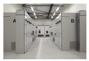
Légende Image2 : Les alimentations redondantes A et B sont assurées par le système de barres-bus Eaton, deux armoires Capitole 40 de 4000 A ainsi qu'un système de secours Capitole 40 BT de 6300 A alimentés via deux unités RMU Xiria.
